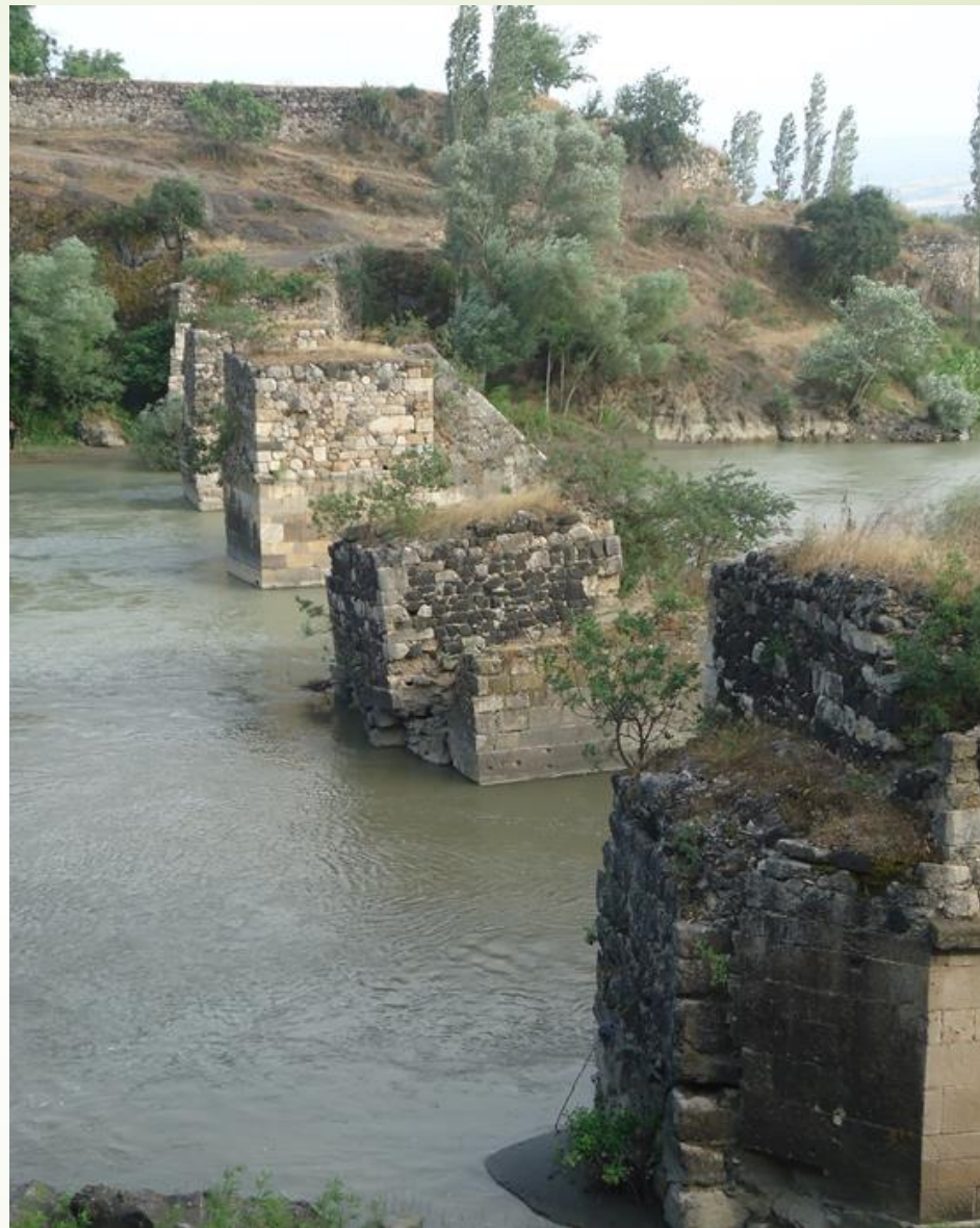
Yeşilırmak ile Kelkit Çayının birleştiği yerde olan Hidirlik (Kale) Köprüsü
