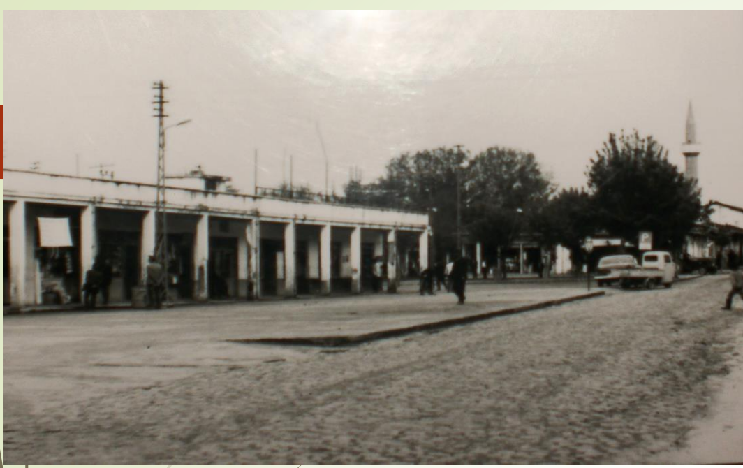
Hal Binasının Güney Cephesi
