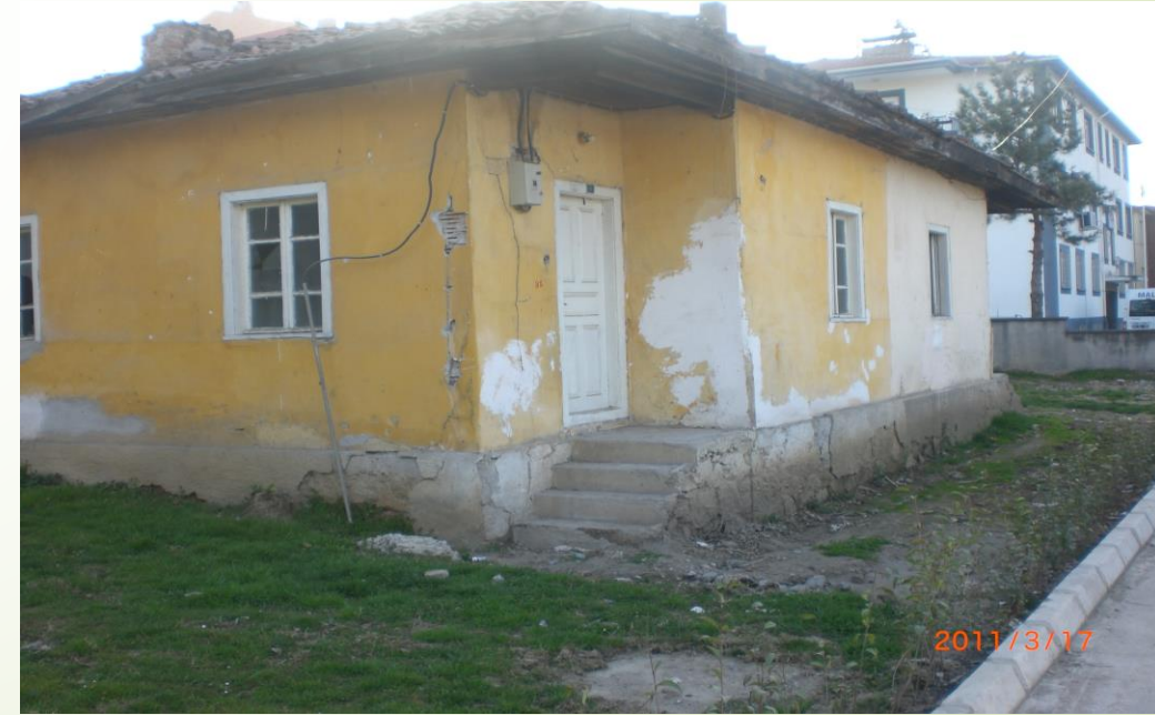
Memur Evlerinin Yıkılmadan Önceki Hali
