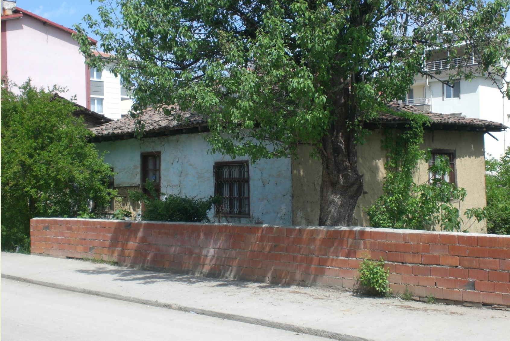
Deprem Sonrası Yapılan, Sayıları Gittikçe Azalan Deprem Evlerinden (2018)
