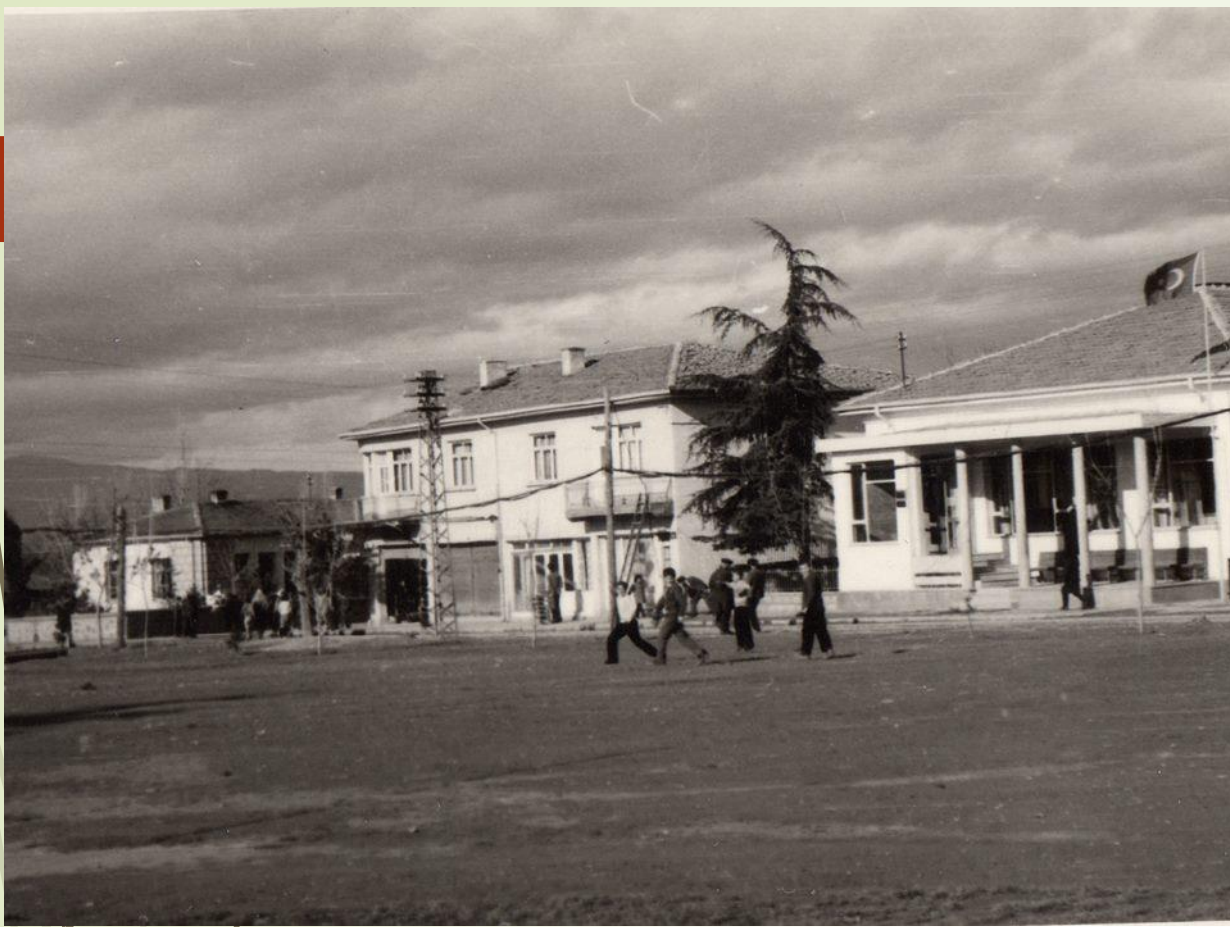
Solda Yer Alan Bina Ziraat Bankası
