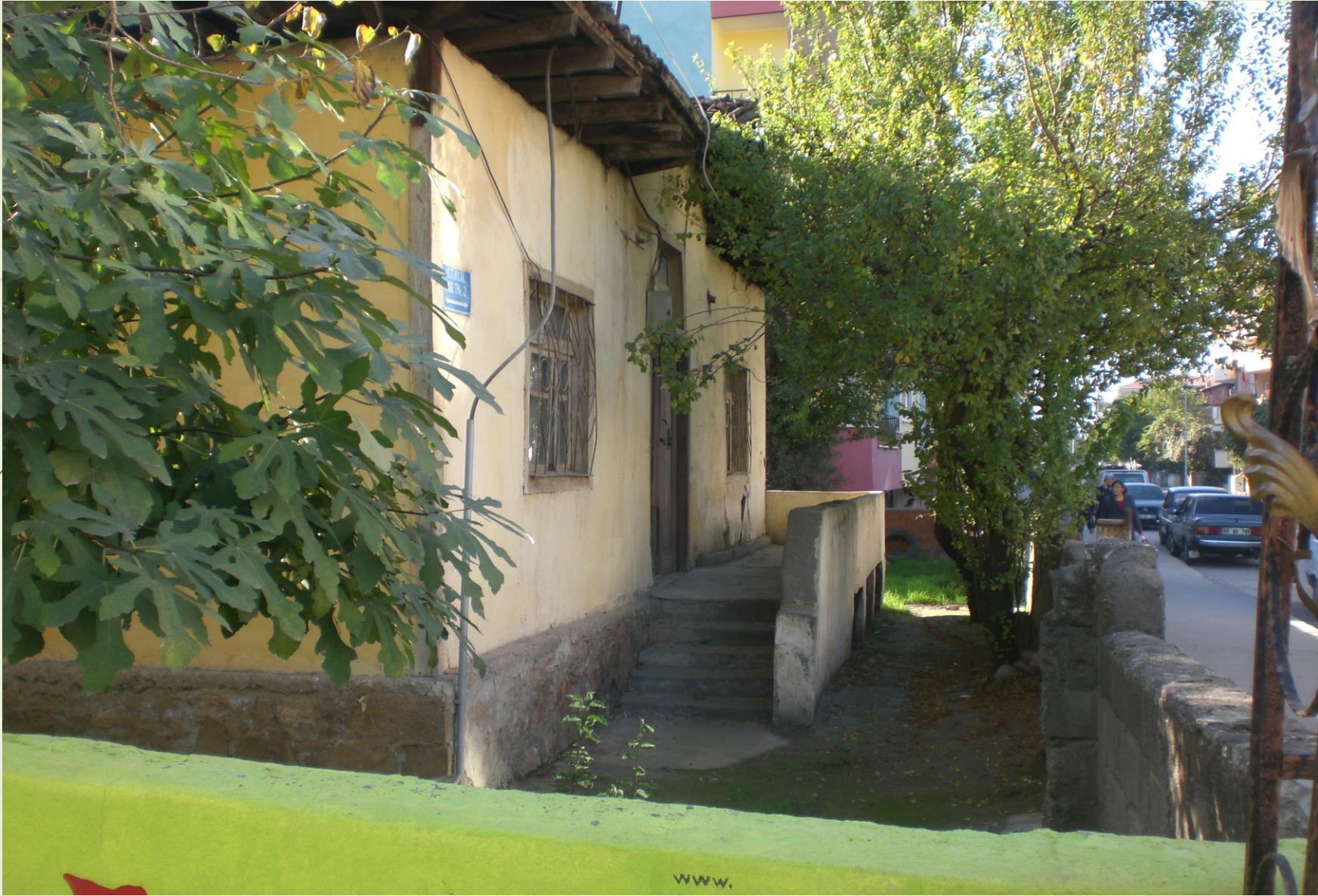
Deprem Sonrası Yapılan, Sayıları Gittikçe Azalan Deprem Evlerinden (2016)
