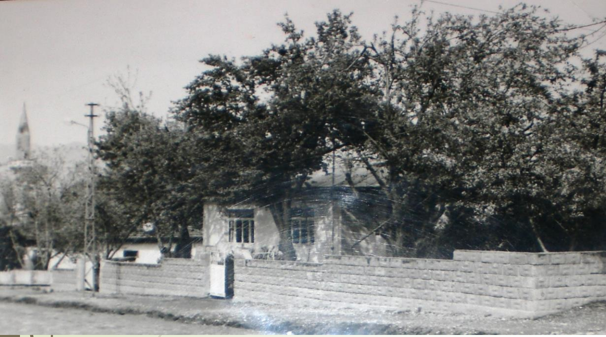
Halk Eğitim Merkezi Binası
