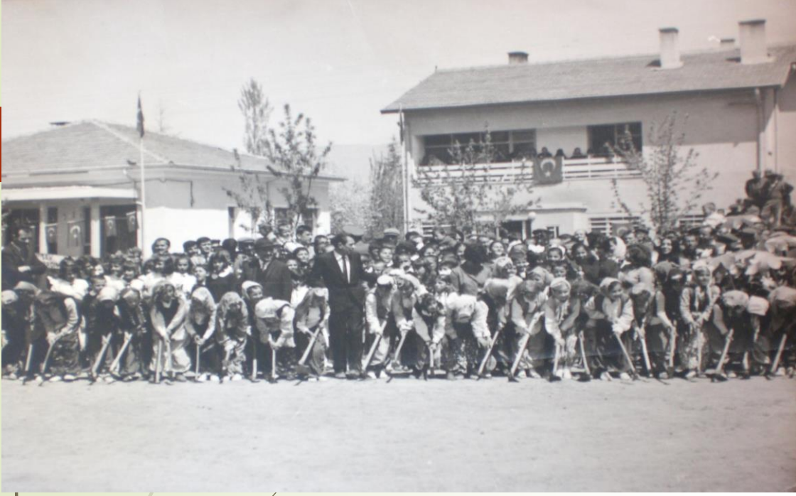
Solda Yer Alan Bina Ziraat Bankası
